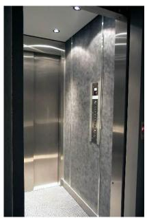
Der Begriff steht nicht nur für den vom Benutzer sichtbaren und betretbaren Kabineneinsatz, sondern für die gesamte Konstruktionseinheit welche an den Tragseilen hängt.
