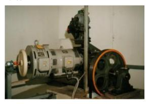
Der Elektro - Antrieb ist am weitesten verbreitet. Er wird bei Aufzügen mit Seilführung eingesetzt. Hierbei treibt der Elektromotor direkt oder über ein Getriebe ein Treibrad an. Dieses Treibrad bewegt durch Reibung die Tragseile, und somit die Kabine in die gewünschte Richtung.
