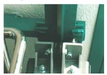
Bei den Führungsschienen handelt es sich um Profil - Schienen, die fest in den Fahrschacht verankert sind. Sie dienen im wesentlichen der Führung des Fahrkorbs im Fahrschacht. Dieser ist mit sogenannten Führungsschuhen mit den Schienen verbunden. Des weiteren werden von den Führungsschienen die Kräfte, welche beim Ansprechen der Fangvorrichtung auftreten, aufgenommen und in das Fundament des Gebäudes eingeleitet.
