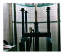
Die Schachtgrube stellt den unteren Überfahrweg des Schachts dar, welcher mit Puffern versehen ist. Der verbleibende Raum dient dem unter den Aufzug arbeitendem Wartungspersonal als Schutzraum.
