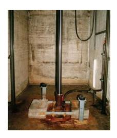
Die zweite große Gruppe von Aufzügen wird hydraulisch betrieben. Hier kommt im allgemeinen eine von einen E-Motor angetriebene Ölpumpe zum Einsatz. Ihr Ölstrom wird über Steuerventile (mechanisch, mit Öldruck oder elektronisch gesteuert) zu einen Hubkolben geführt. Dieser Hebt die Kabine an. Das Abfahren der Kabine wird durch das Eigengewicht ermöglicht.
