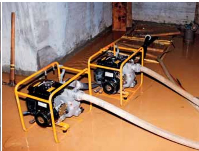
02. Juli 1997: Überflutung einer Baustelle, Johann-Maus-Straße
