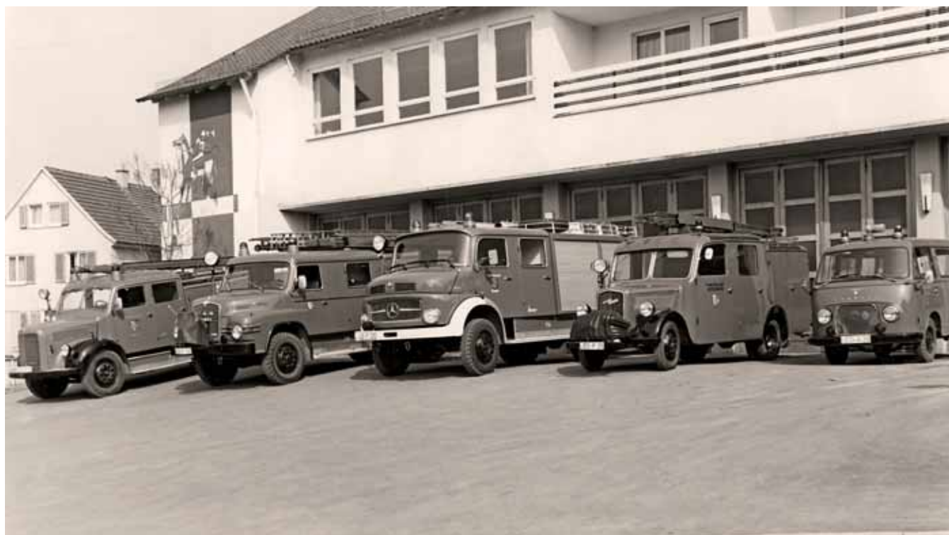
1974 war es soweit: Nur 15 Jahre nach Fertigstellung sind alle Stellplätze des großzügig gebauten Feuerwehrhauses belegt. Mit TLF 15, LF 16 TS, TLF 16, LF 8 und MTW hielt die Ausstattung der Feuerwehr Schritt mit der raschen städtebaulichen Entwicklung.
