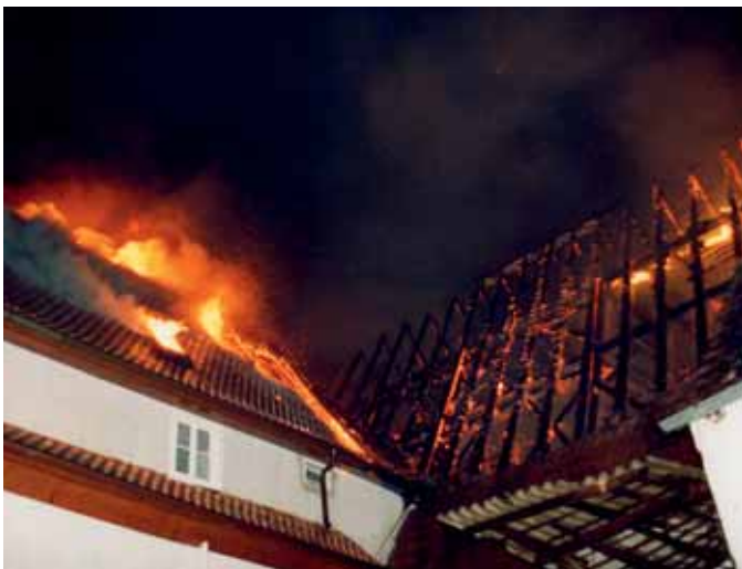
27. Oktober 2003: Großbrand, Hochdorfer Straße
