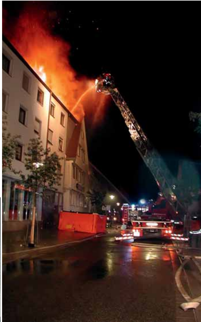
07. Juni 2004: Dachstuhlbrand, Marktstraße
