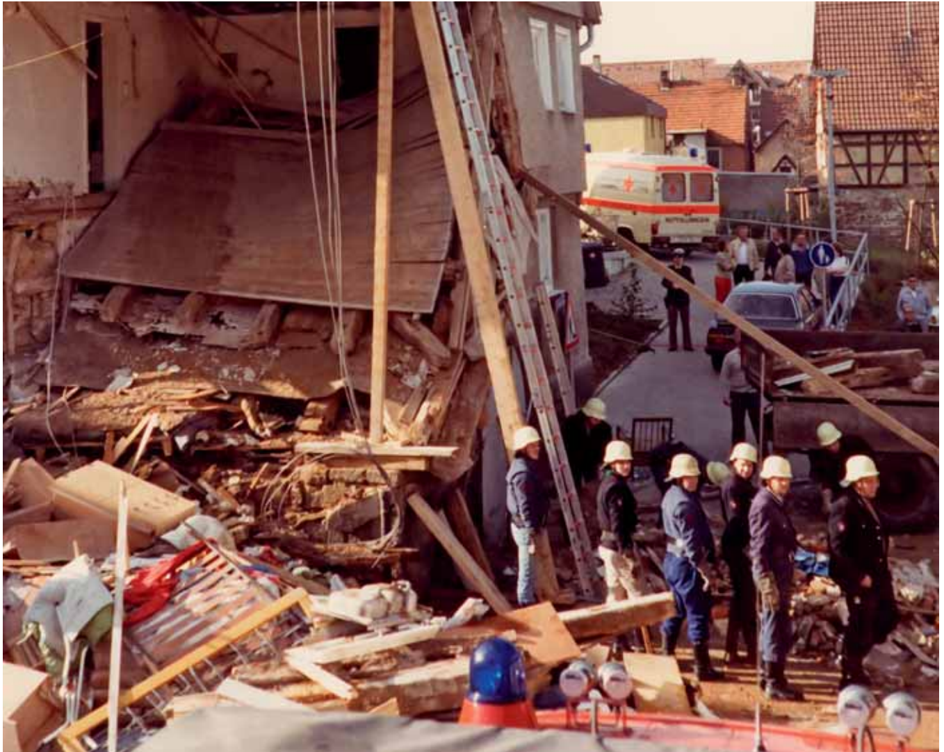
22. Oktober 1984: Gasexplosion, Mittlere Straße
