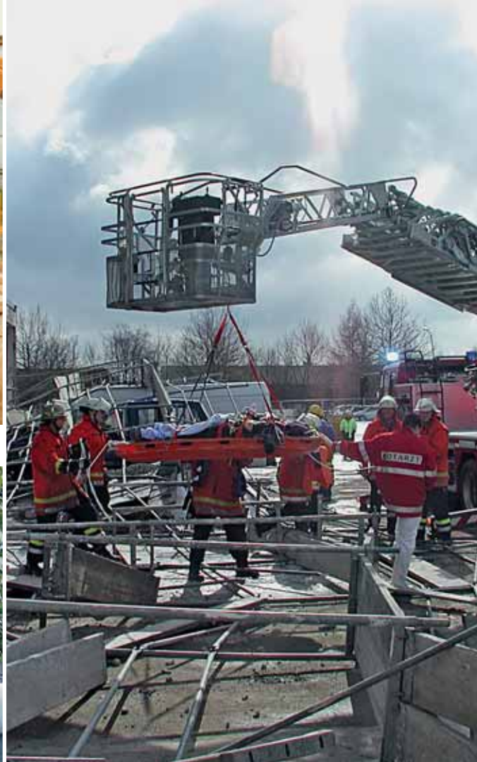
07. März 2006: Bauunfall, Borsigstraße
