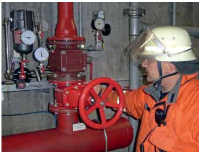
29. Dezember 2007: Störung Sprinkleranlage, Berblingerstraße
