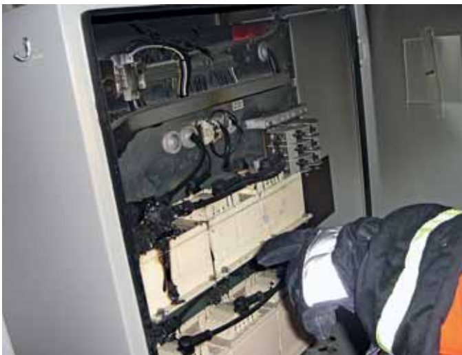
31. Oktober 2007: Elektrobrand, Stuttgarter Straße
