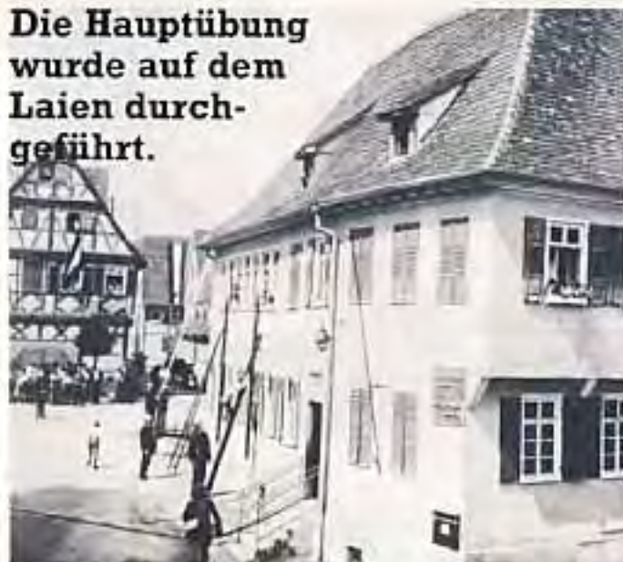
Die Steigerabteilung im Einsatz.
