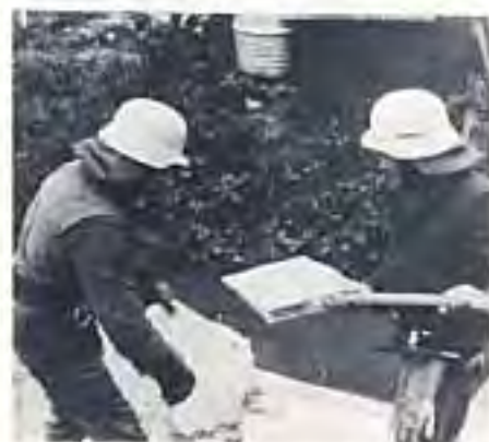
Das von einem chemischen Bindemittel aufgenommene Öl wird abgeschöpft.
