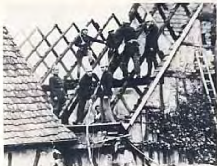
Nach dem Brand der Krüsen-Scheuer
