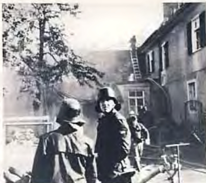
Großbrand in der Clemensstraße. Eine angrenzende Scheune an die Schuhfabrik Dobelmann brannte aus.
